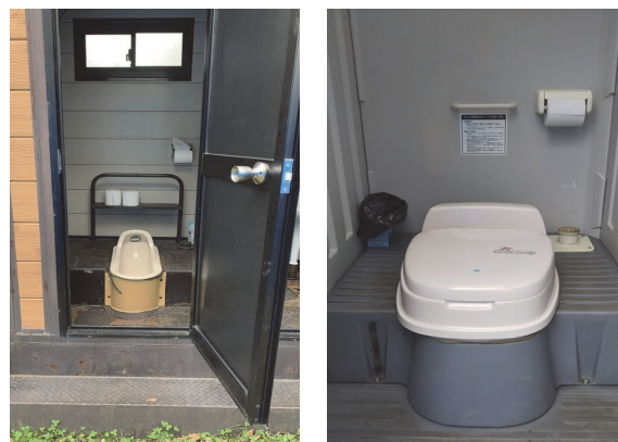
写真8 厚真町避難所の仮設トイレ 和式と洋式の両タイプが設置されていた。 2018年9月 北海道胆振東部地震 厚真町 仮設トイレ 筆者撮影
