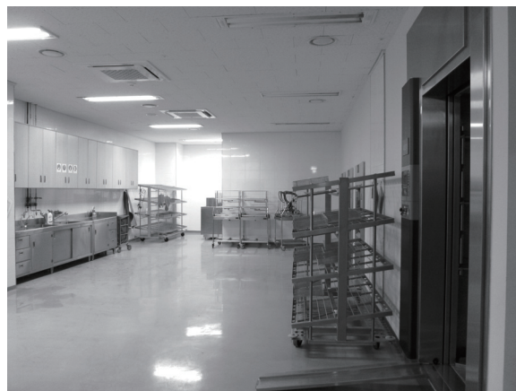
中央材料室 汚染エリア
