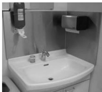
壁のクロスを除去しステンレス製の鉄板を取り付けた (ペーパータオルを取り出す際に水が飛んでも壁が汚染されない素材とした)
