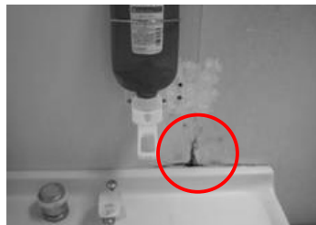
シンクと壁の境界に黒色の汚染が付着
