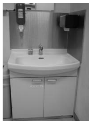
壁のクロスを除去しステンレス製の鉄板を取り付けた (ペーパータオルを取り出す際に水が飛んでも壁が汚染されない素材とした)
